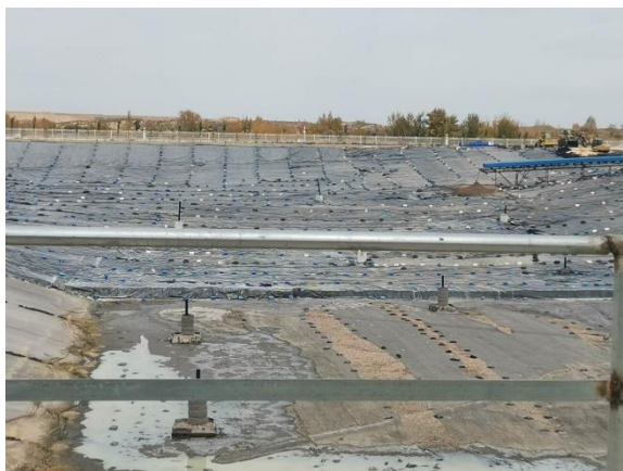
东侧柔性填埋场
