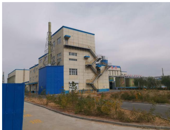
南侧无机暂存库
