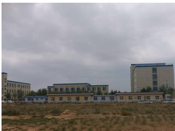
西侧职工宿舍楼及办公楼
