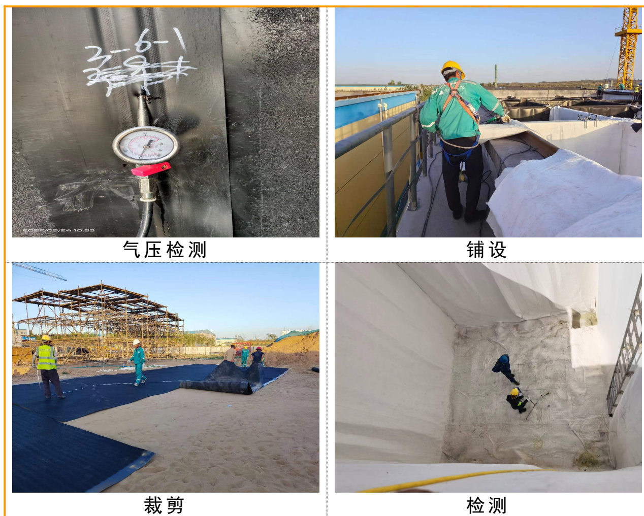
图 3.6-2 项目施工现场照片
